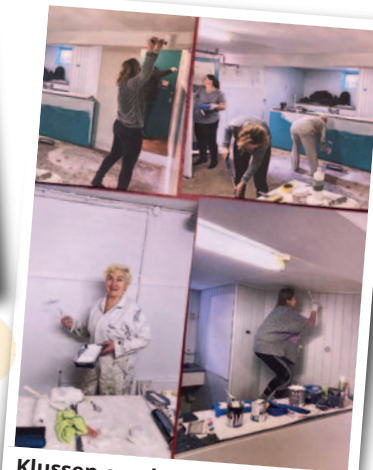
Klussen om de ruimte van We Share gebruiksklaar te krijgen.
